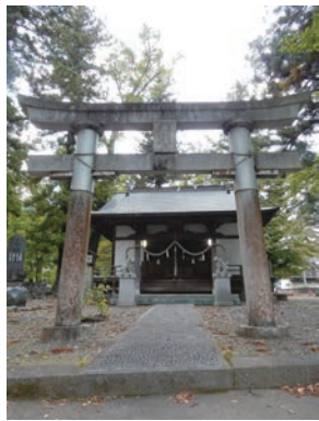
左：石船神社の石鳥居。金属で補強された部分だけ明るい灰色だ 右：戸沢の御嶽神社の鳥居。与繩の御嶽神社のものと形が似ている
