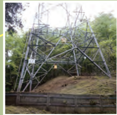
07 この鉄塔付近に分かれ道があります
