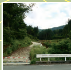
01 砂防ダム建設工事でひらけています
