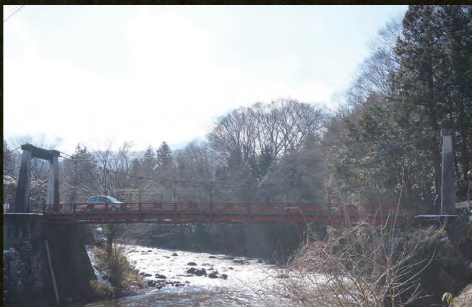
上：戦前 / 下：2016.02.08 古写真の説明には「川棚橋を吊り橋にかけ替えのときと思われる」とある。現在、戦前の写真で写っている下の橋はなくなっており、橋の名前も城南橋と変わっていた。城南橋は車が通ることができる橋に変わっていた。
