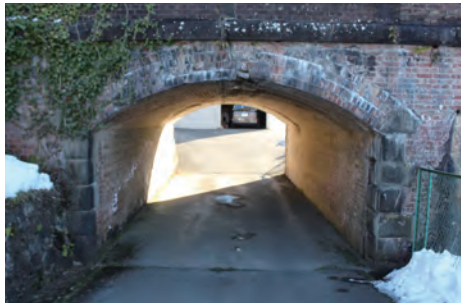
橋の下の小さなトンネル
