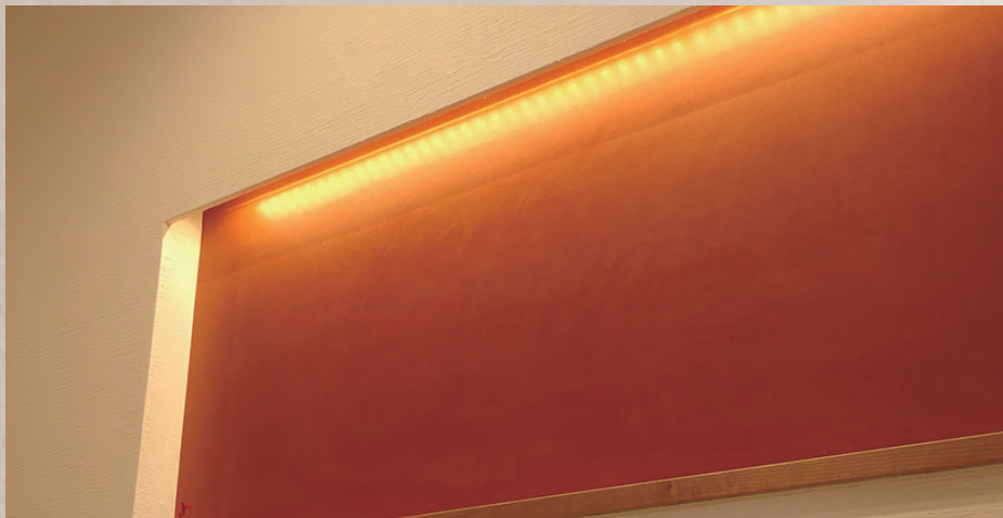
大津磨きが施された壁。家主のかたは決して触らず大切に扱っている
