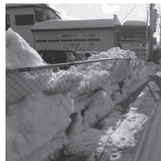
雪の重みでフェンスが曲がってしまっている (2014.2.22)
