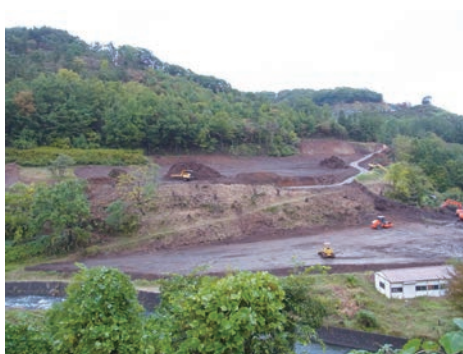
突然、工事が始まった。ここには大規模なソーラーパネルが設置されるという (2014.10.23)
