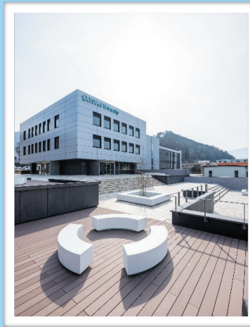
エントランス広場
